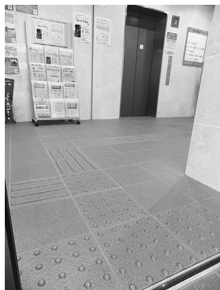
1F 入り口からの点字ブロック
